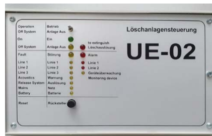
Steuereinheit der Feuerunterdrückungseinrichtung mit Aktivierungsschalter
