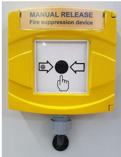
Handauslösung der Feuerunterdrückungseinrichtung
