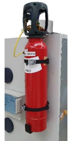
CO 2 Druckgasflasche
